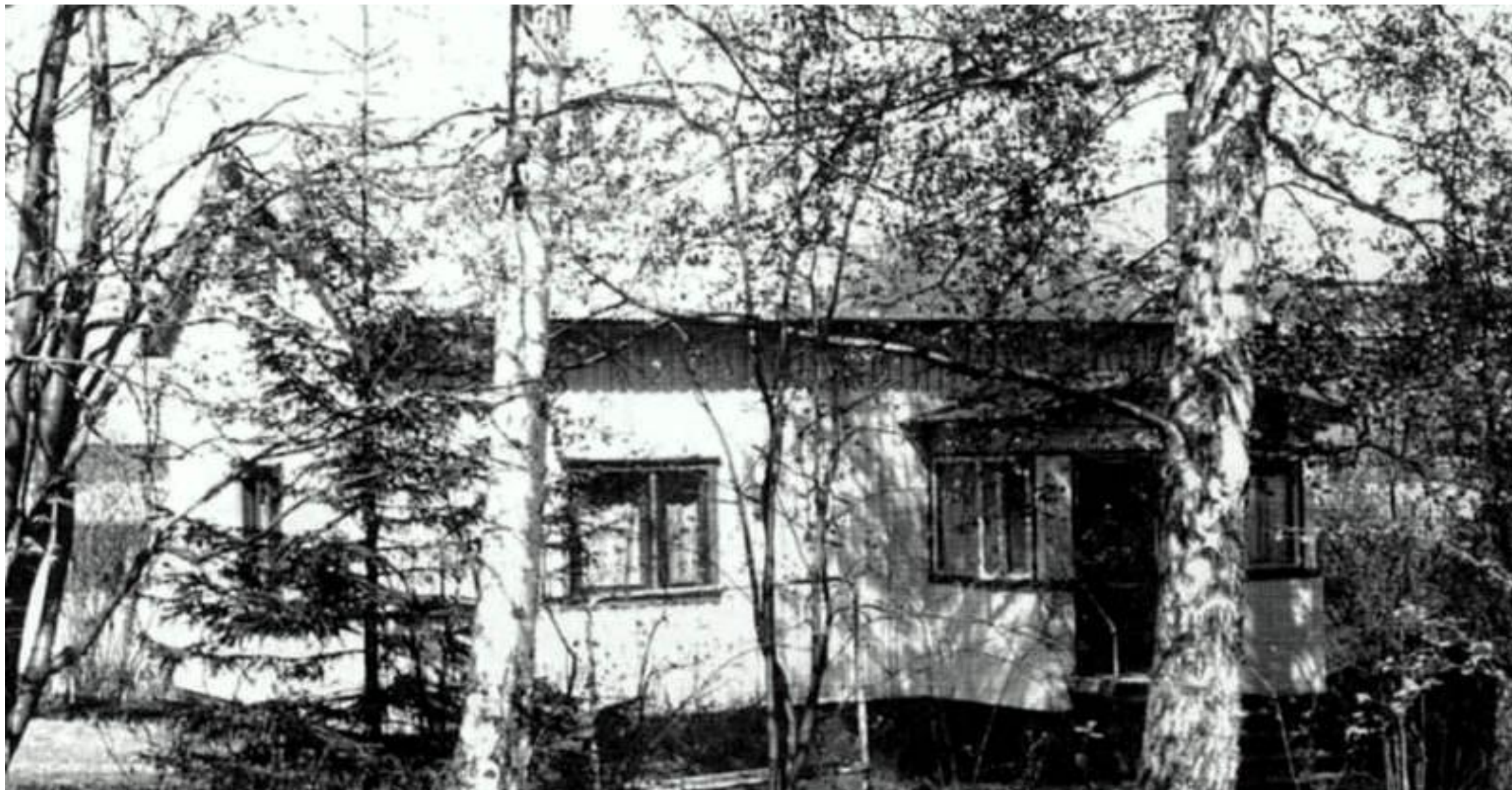
Ruotsalaisen lahjatalotyyppi 3. Urho Orola, Jalmari Peltonen 1940. Maaseudulle suunniteltuja taloja rakennettiin eniten taajamiin
